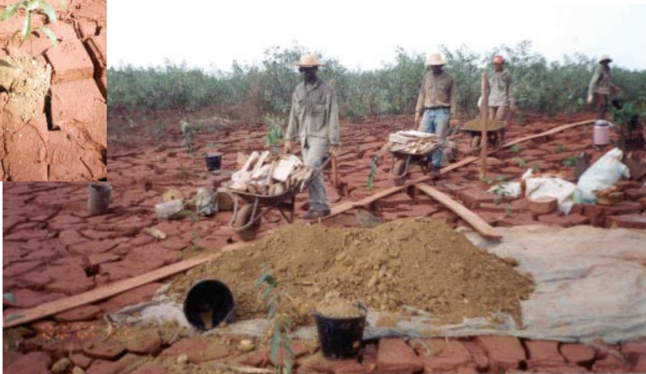
Replanteio para cobrir falhas no SP1: utilização de terra vegetal para acelerar a recuperação (detalhe) Replanting on the SP1 reservoir to have failures filled up: utilization of organic soil to accelerate recovery (detail)
