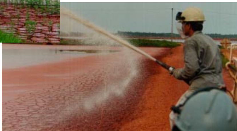
On the left, hydroseeding activities in october' 1998, and a view of the area (above) in june' 1999 À esquerda, detalhe da atividade de hidrossemeadura, em outubro de 1998, e aspecto da área hidrossemeada, em junho de 1999 (acima)
