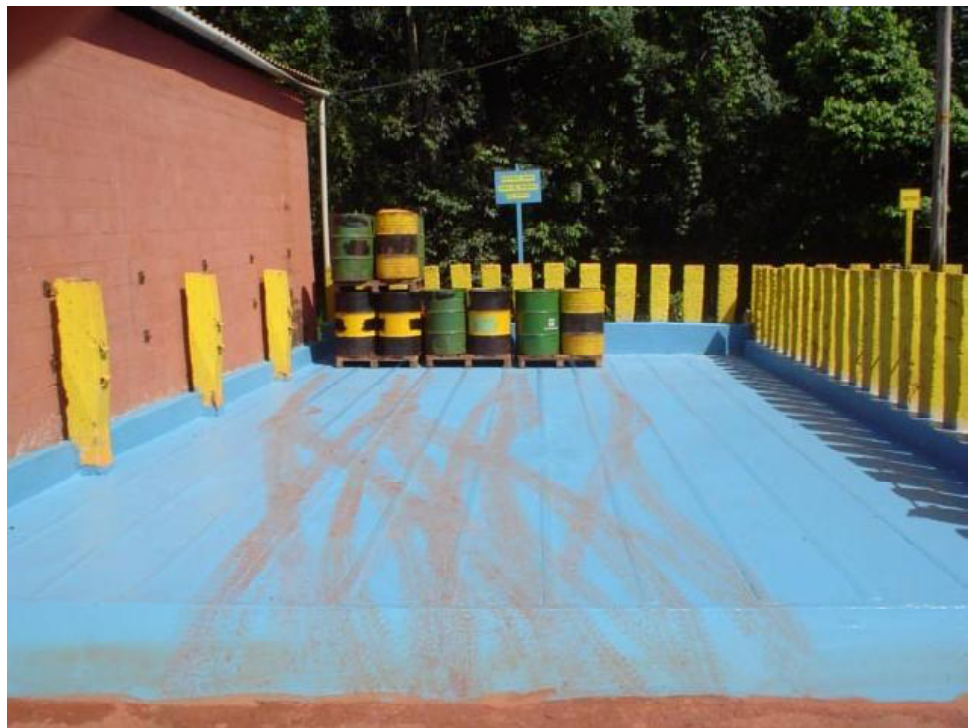
Baia de contenção de resíduos, localizada na Mina Residue yard at MRN's bauxite deposit area.
